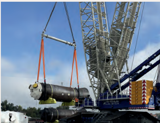
Chargement d'une partie inférieure d'un générateur de vapeur sur une barge au port de Neuf-Brisach.
